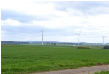
In der Ferne drehen die Windräder bereits ihre Kreise. In Sichtweite wird nun der neue Mast aufgestellt. swb-Bild: Ikr
